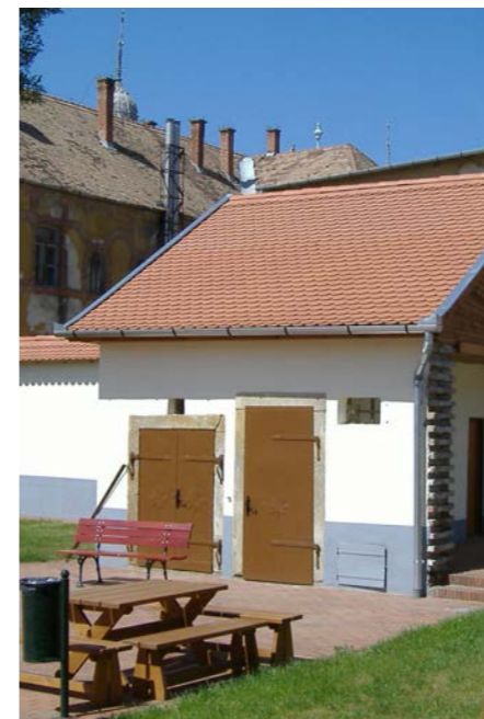
Kő ajtókeretek a melléképületen
