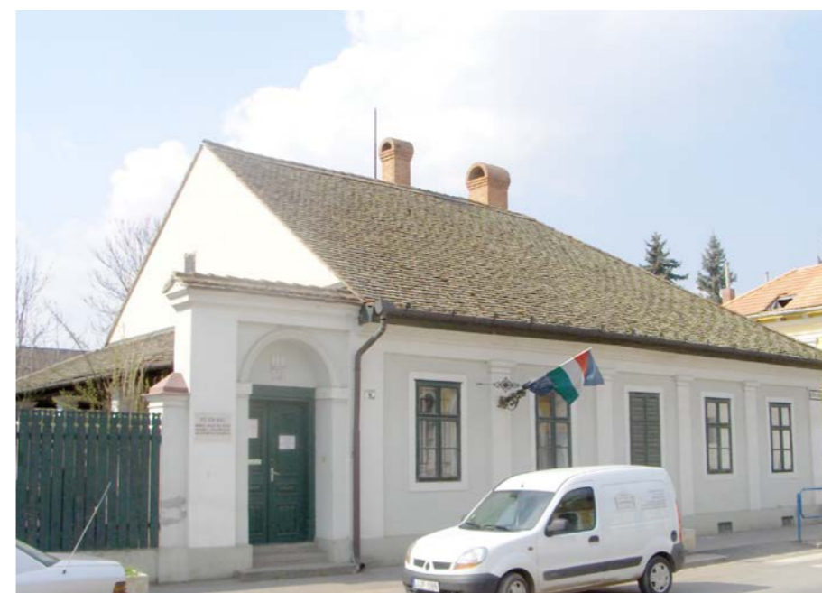
Felújított utcai homlokzat
