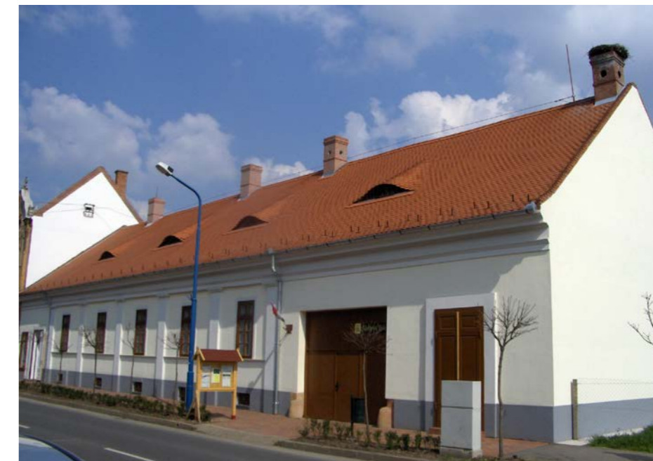
Felújított utcai homlokzat
