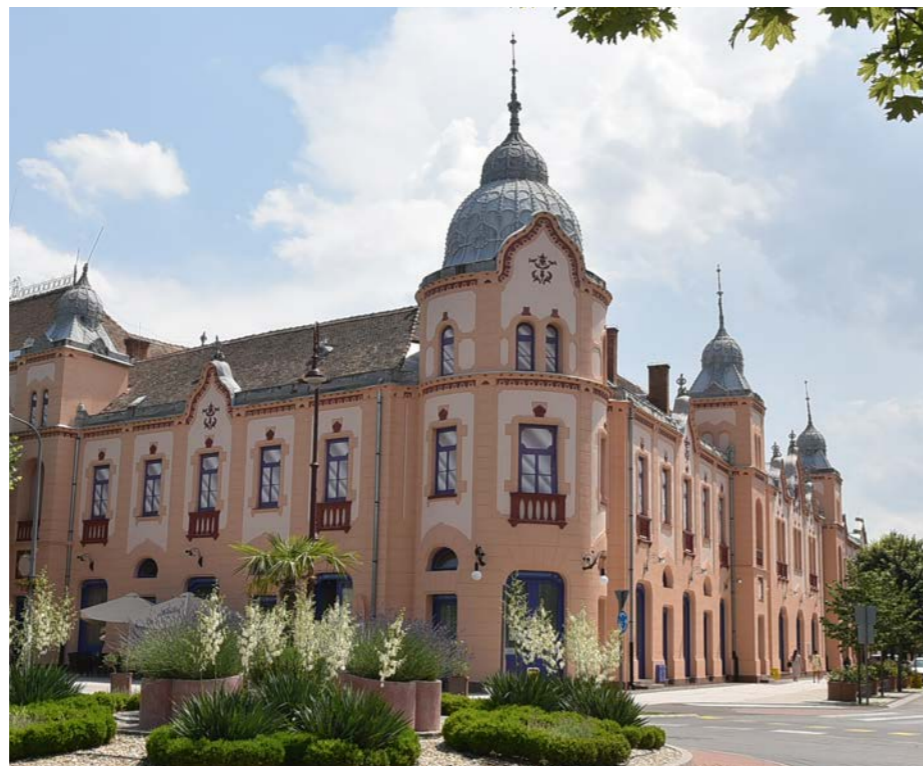
A felújítás Szabó János építész tervei alapján készül
