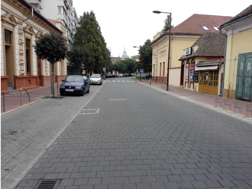
9. kép. Ady Endre utcai kerékpártámaszok (bal oldalon az előírásoknak megfelelő, jobb oldalon nem megfelelő)
